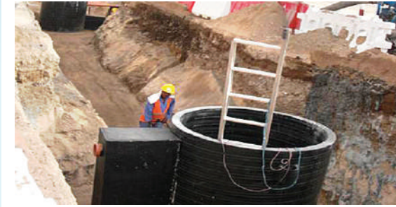
CONSTRUCTION OF SEWAGE LINE تمديد وتركيب خطوط معالجة المياه
