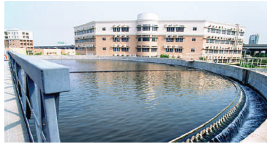
TREATED WATER TANK خزانات المياه المعالجة
